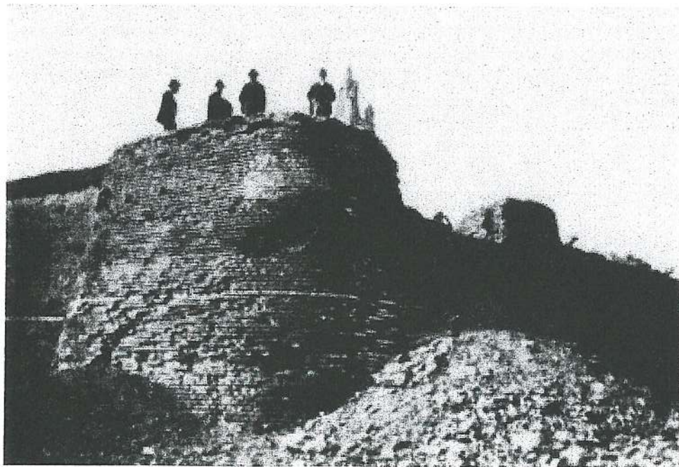
Sopra: Il piccolo baluardo di Borgo Forte in fase di abbattimento
