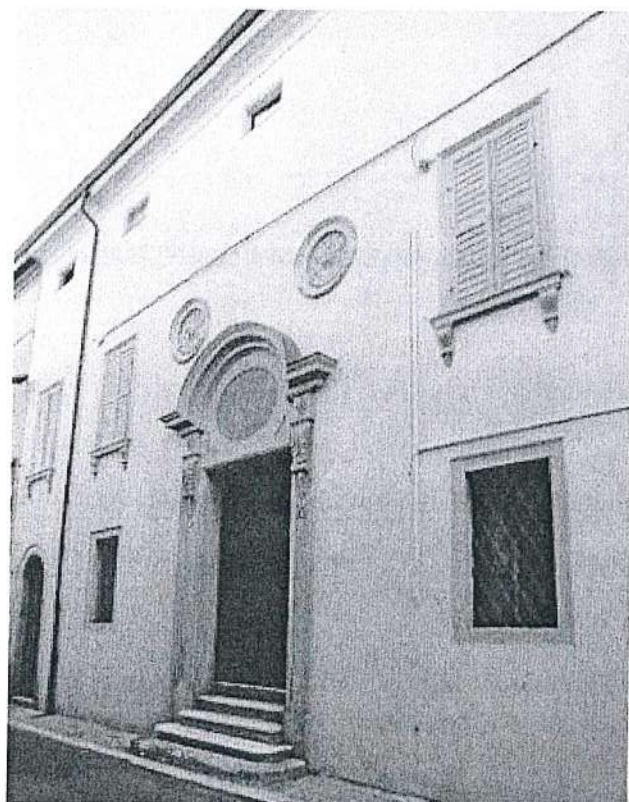
Ingresso della sinagoga ristrutturata in via G. Rovighi
