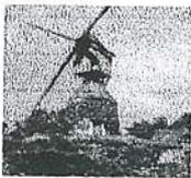
▪ il mulino a vento, costruito dai Persiani nel settimo secolo, che sfrutta l'energia eolica, cioè del vento, per esempio viene usato in Olanda per prosciugare i polders, cioè terreni bonificati difesi da argini sotto il livello del mare
