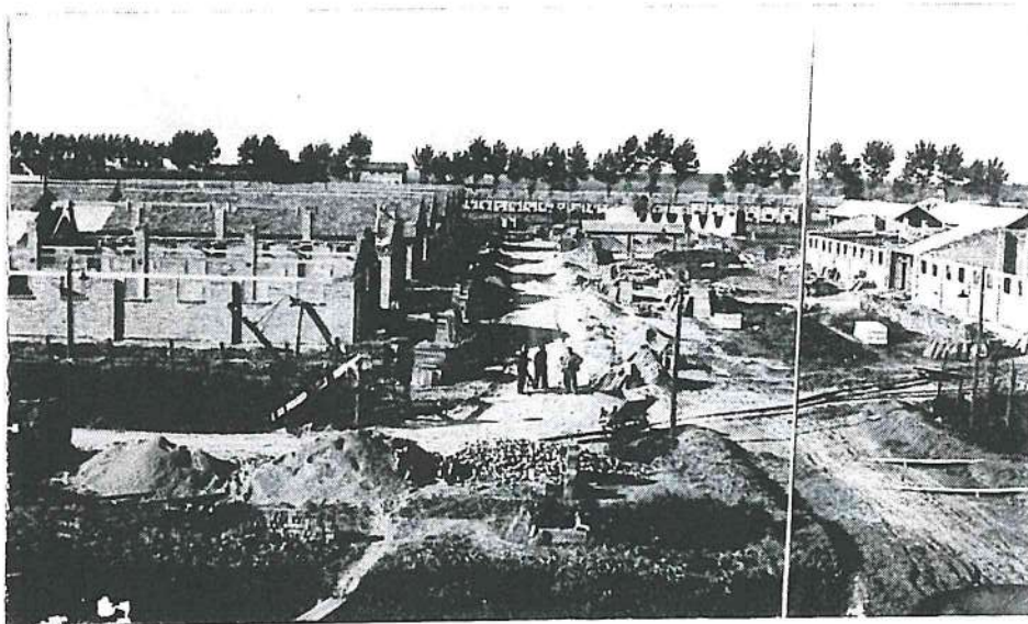
ASCC (Cat.15 cl.7 fasc.5) Campo di concentramento di Fossoli. Atti dal 1942 al 1949. Filza n.3/3 sottofasc.n.2 Costruzione di baracche per prigionieri al posto delle tende.
